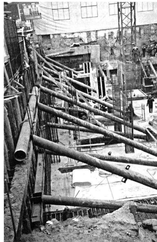
Рис. 1.16. Фрагмент ограждения котлована строящегося общественно-жилого комплекса в Филипповском переулке в Москве
