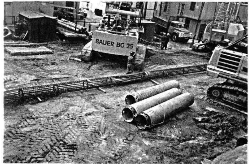
Рис. 1.30. Обсадные трубы и арматурный каркас буронабивных свай \varnothing 800 мм
