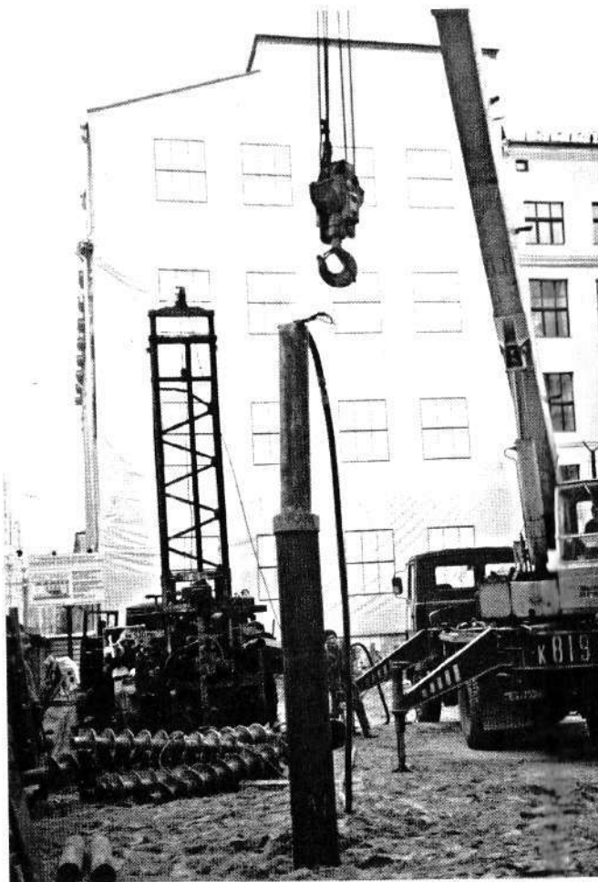
Рис. 1.15. Погружение в предварительно пробуренную скважину металлической трубы пневмопробойником СО-166
