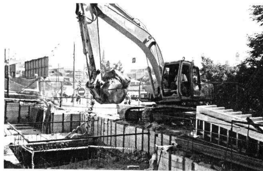
Рис. 1.41. Разработка грунта из-под перекрытия
