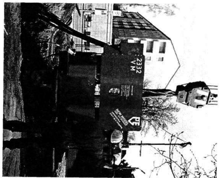
Рис. 4.13. Безрезонансный вибропогружатель РВЕ 2332VM
