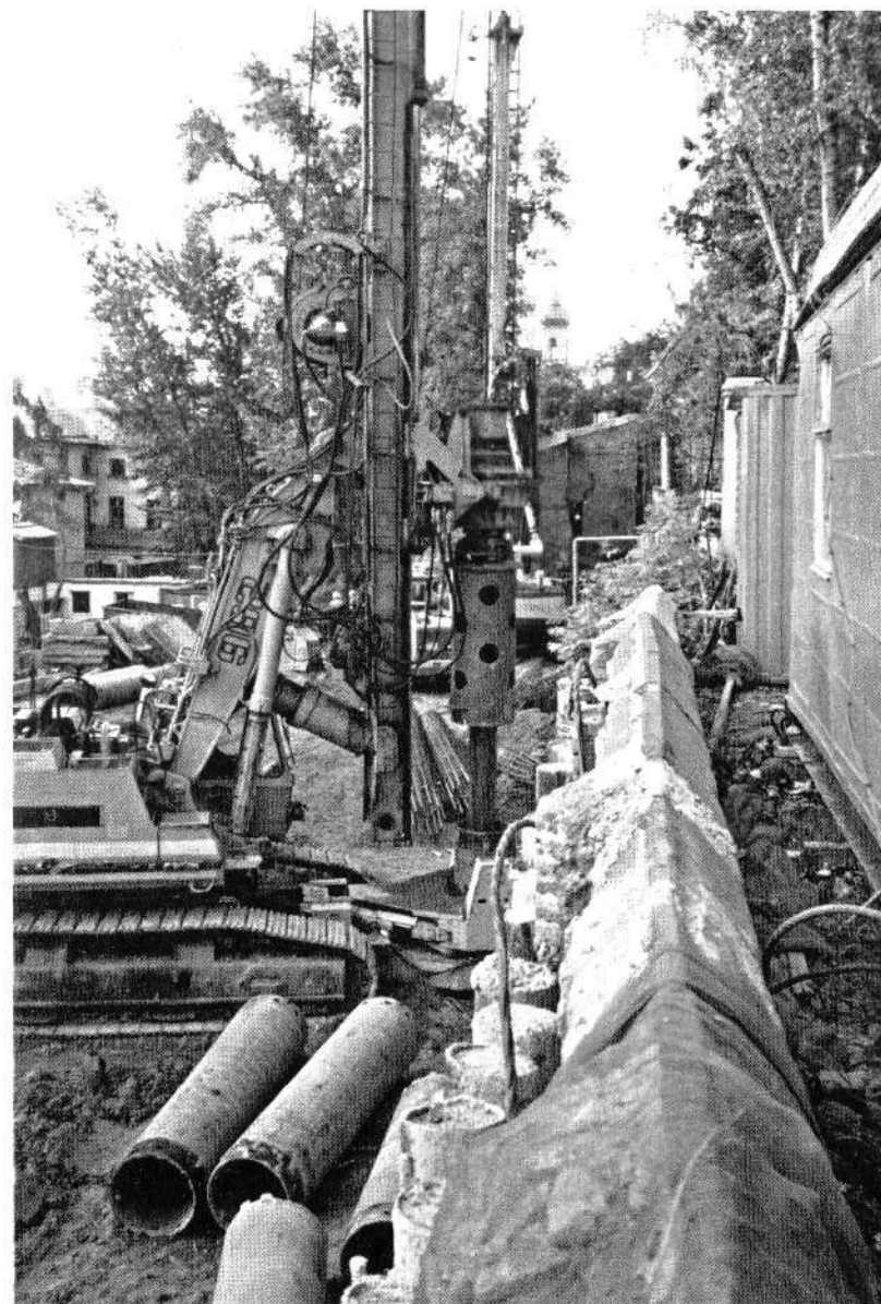
Рис. 1.32. Бурение скважины \varnothing 800 мм самоходной буровой установкой Bauer BG 25
