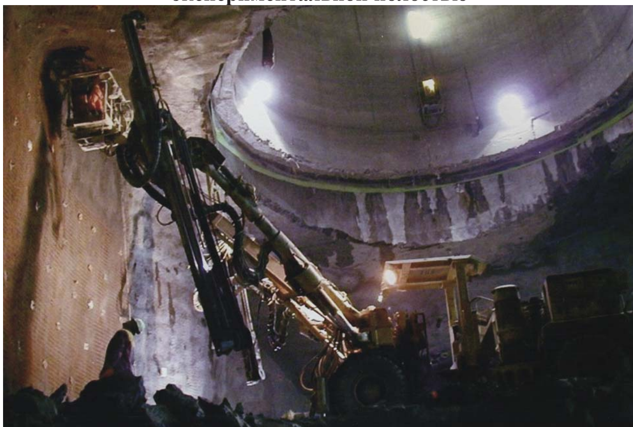
Рис. 4.103. Установка анкерной крепи в сопряжении вертикальной шахты с экспериментальной полостью
