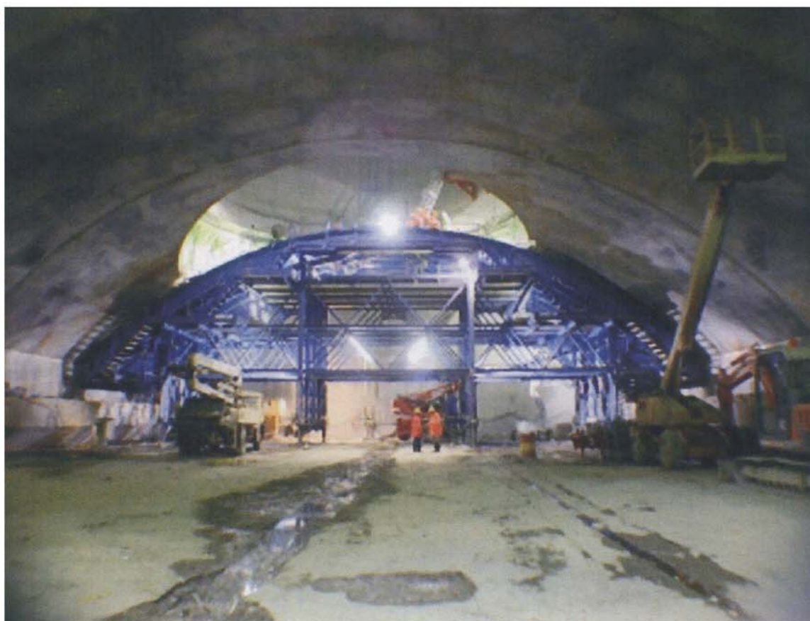
Рис. 4.106. Строительство полости UX15 детектора ATLAS
