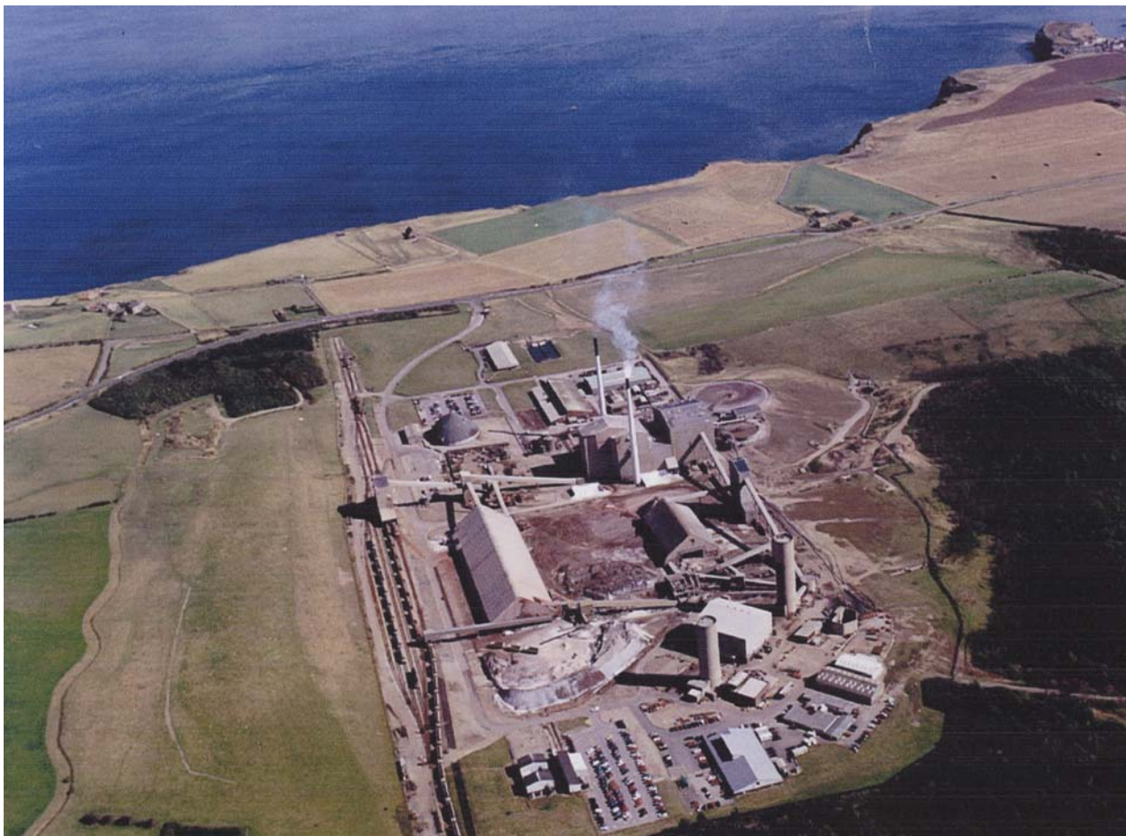
Рис. 4.54. Промышленная площадка шахты Балби
