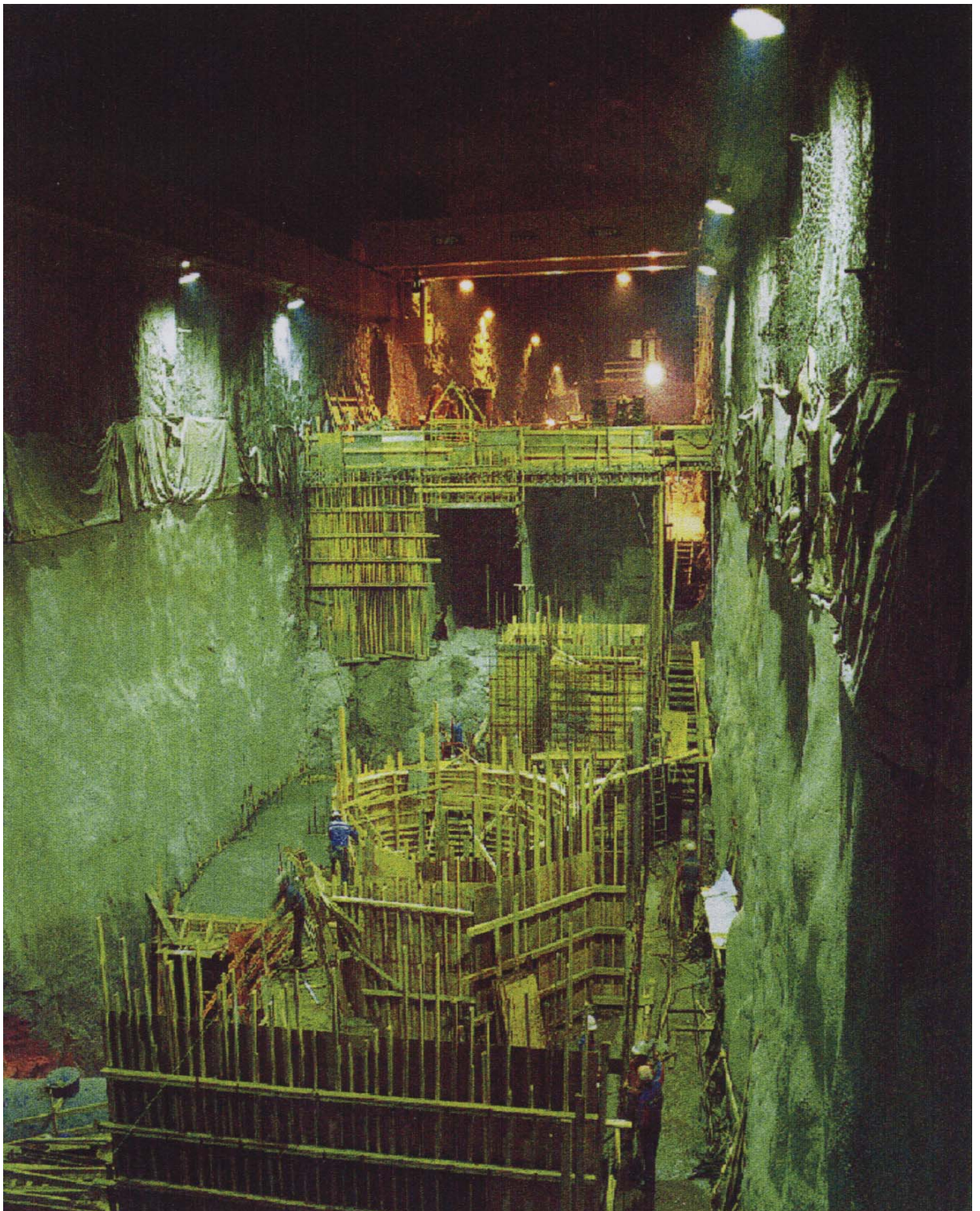
Рис. 2.51. Строительство главного машинного зала подземной электростанции Нью-Скджерка
