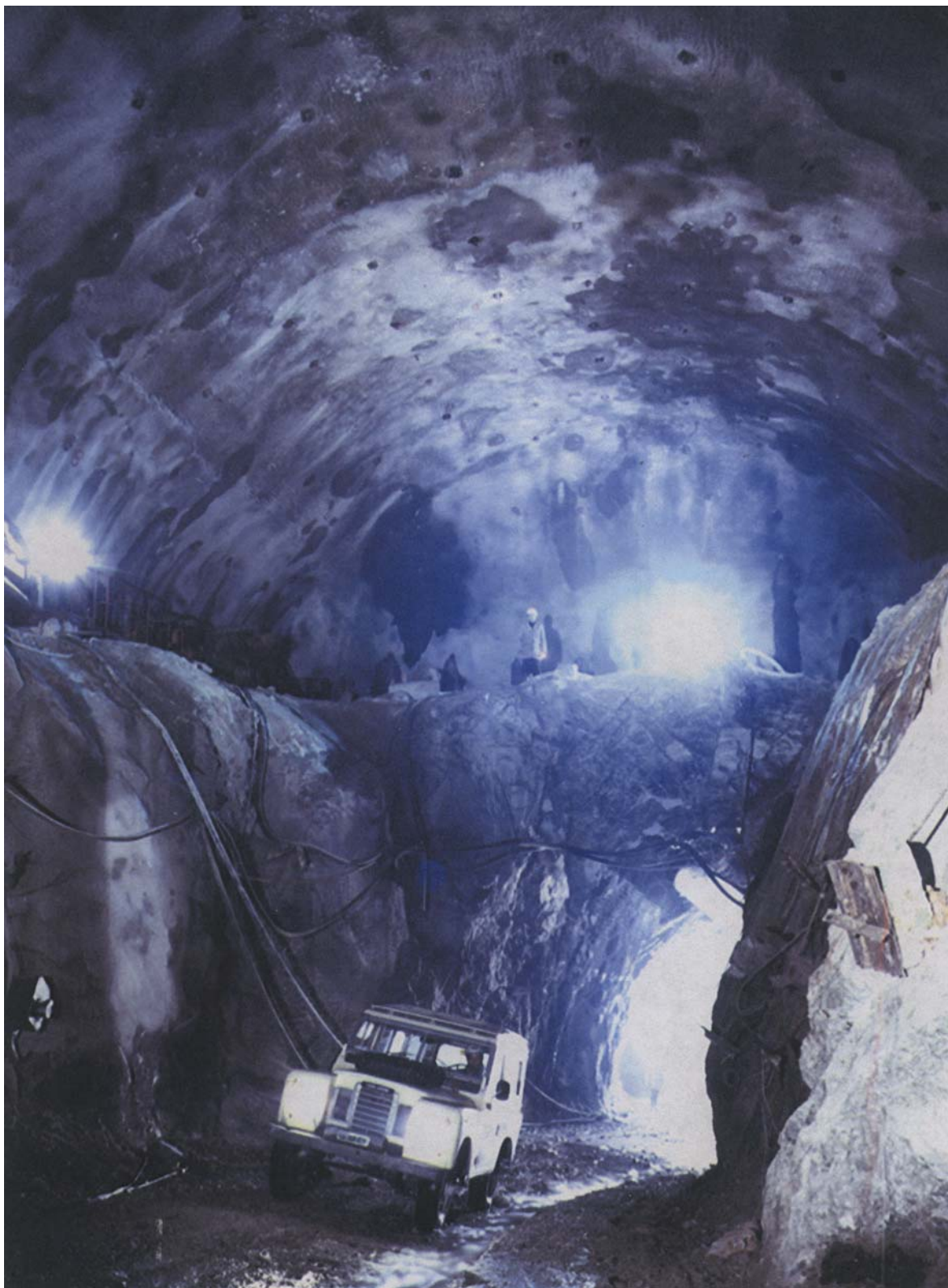
Рис. 4.87. Сооружение лабораторной полости (лаборатория Грэн Сэссо)
