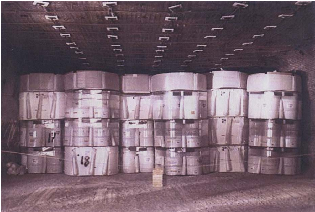
Рис. 3.27. Контейнеры с отходами в помещении хранения
