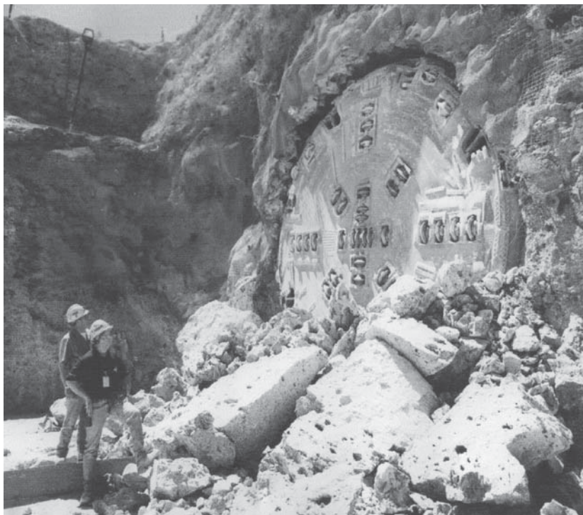
Рис. 3.11. Окончание проходки разведочного туннеля буровой туннельной машиной
