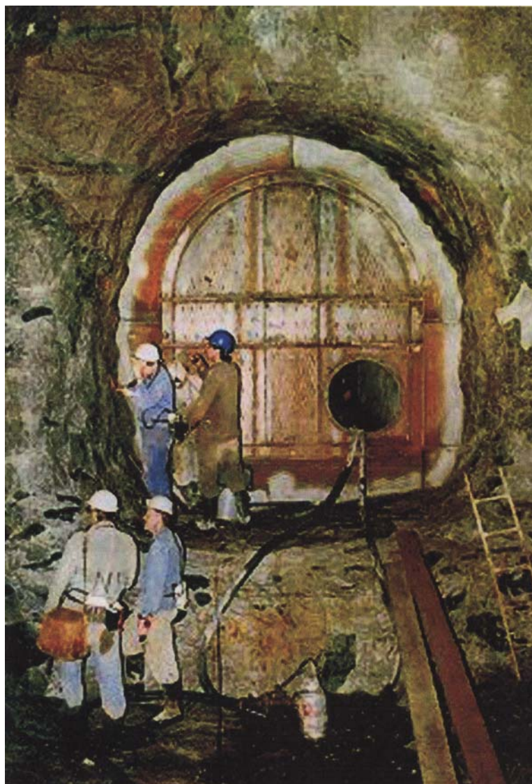
Рис. 2.9. Установка водонепроницаемой перемычки
