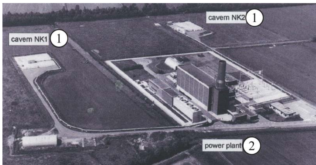
Рис. 2.58. Вид с воздуха на электростанцию Хантдорф
