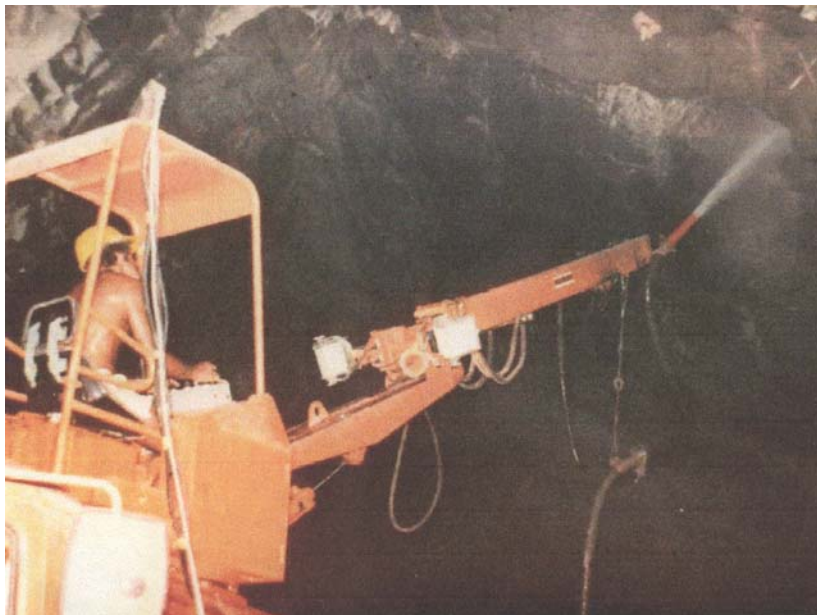
Рис. 1.23. Работы по нанесению набрызгбетона
