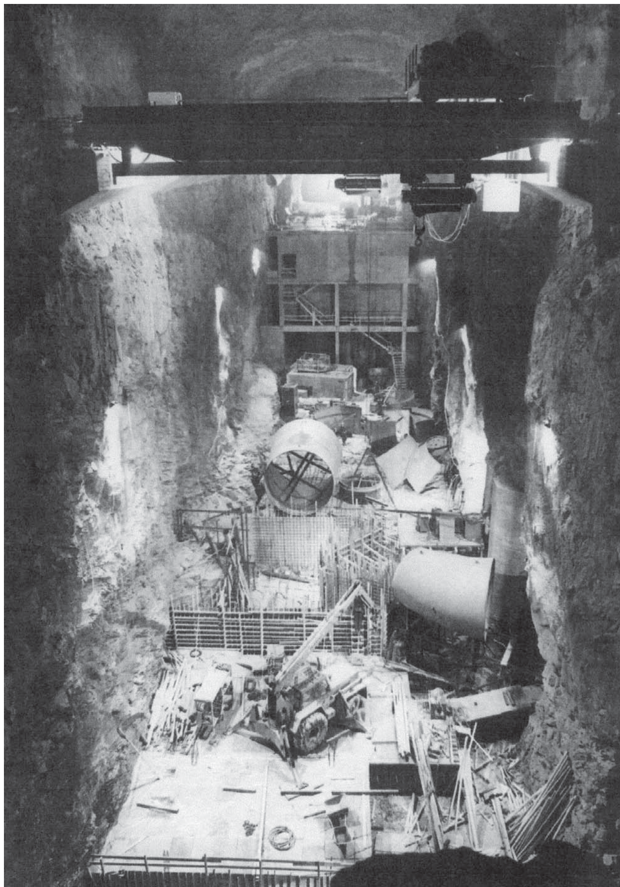
Рис .2.54. Строительство амортизирующей камеры электростанции Квиллдал
