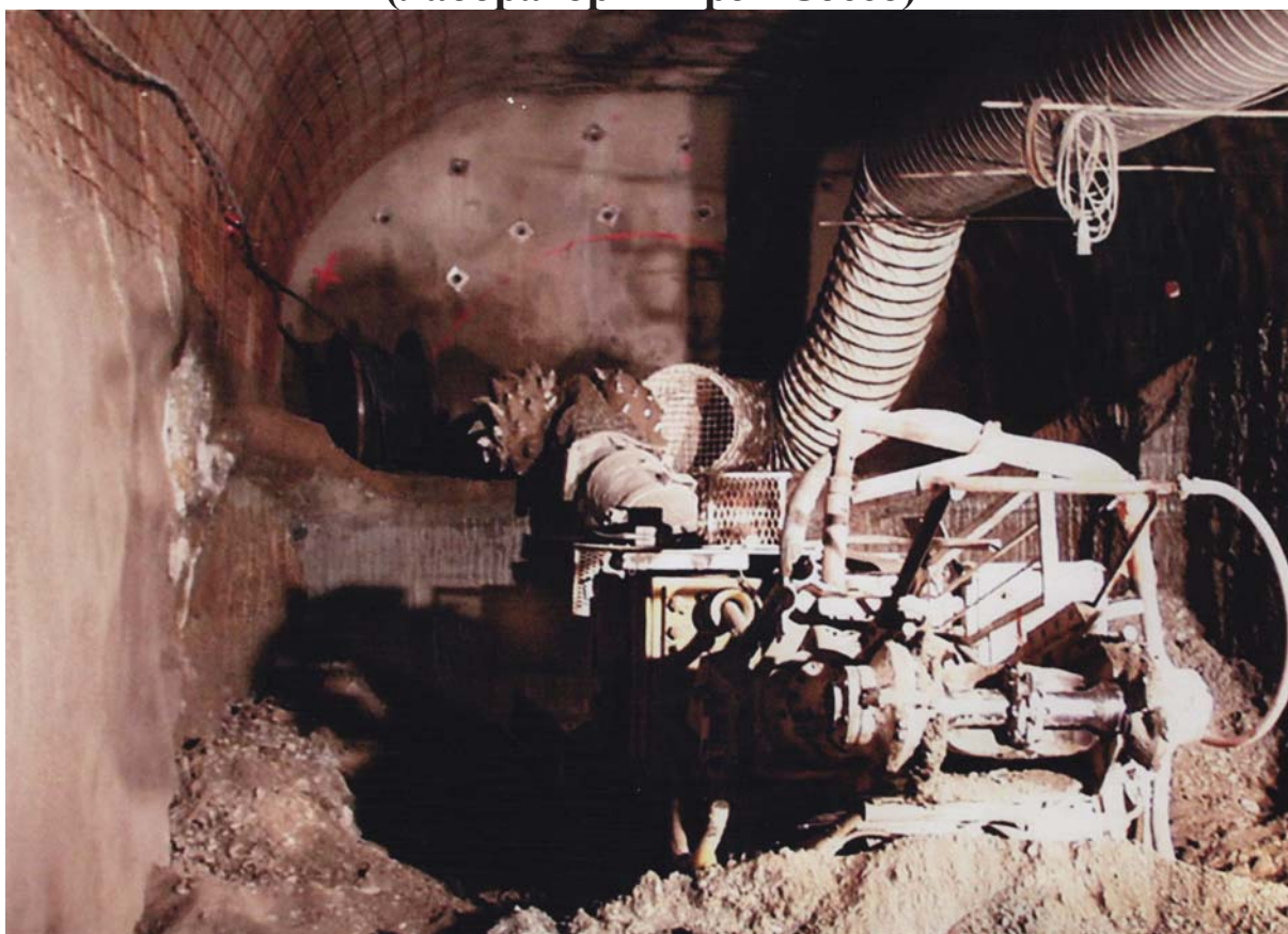
Рис. 4.89. Проходка полости комбайном (лаборатория Грэн Сэссо)
