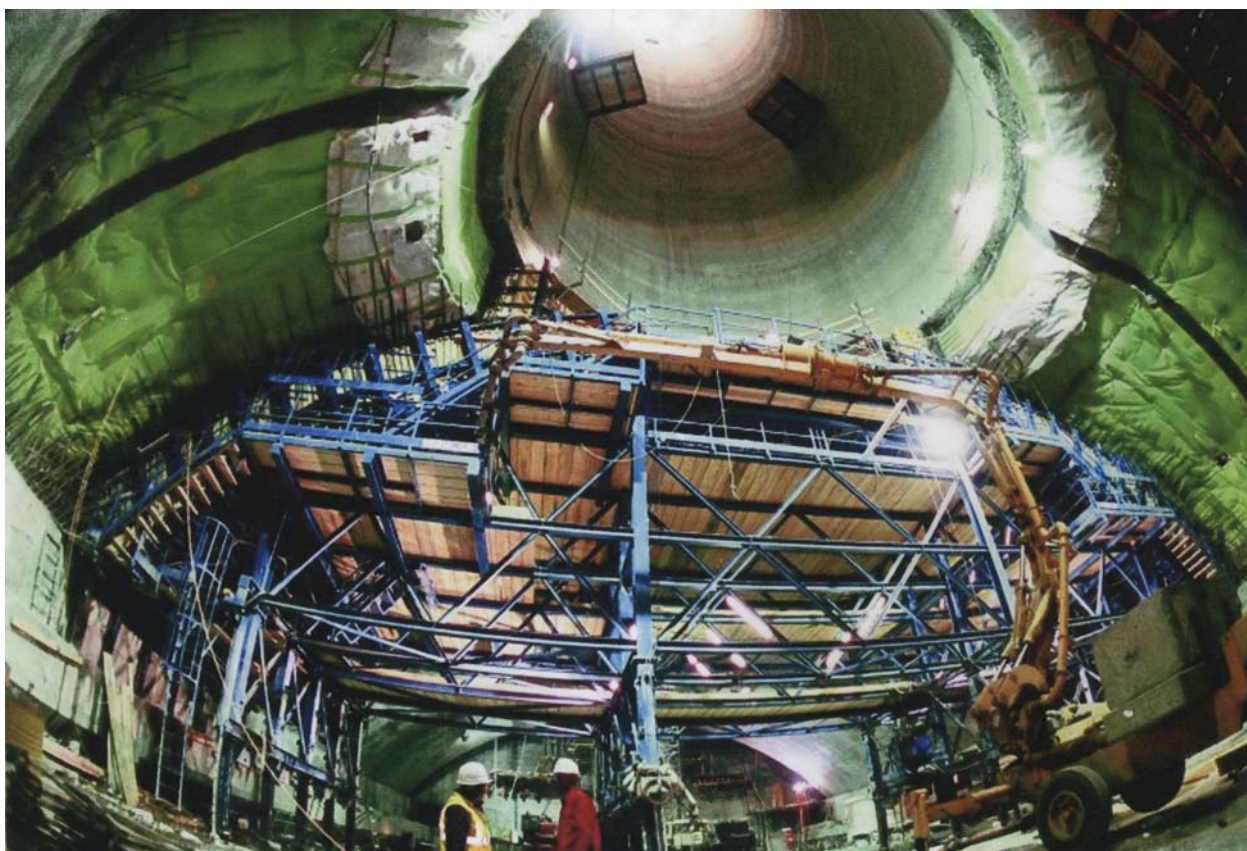
Рис. 4.101 Сооружение сопряжения вертикальной шахты с экспериментальной полостью
