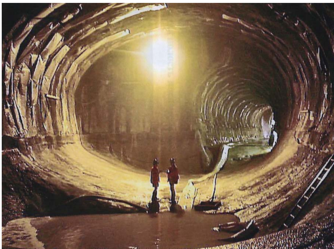
Рис. 1.17. Подземная полость после проведения взрывных работ
