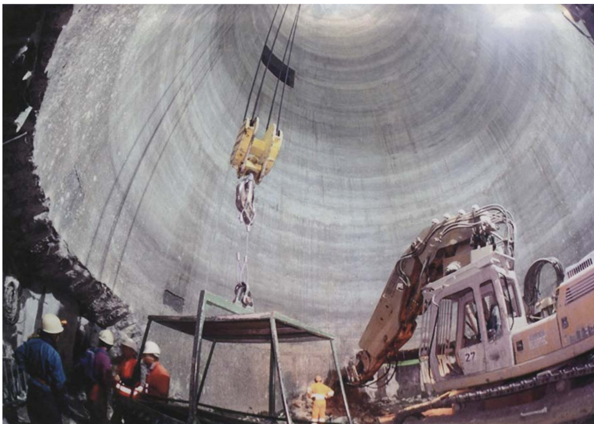
Рис. 4.102. Сооружение сопряжения вертикальной шахты с экспериментальной полостью
