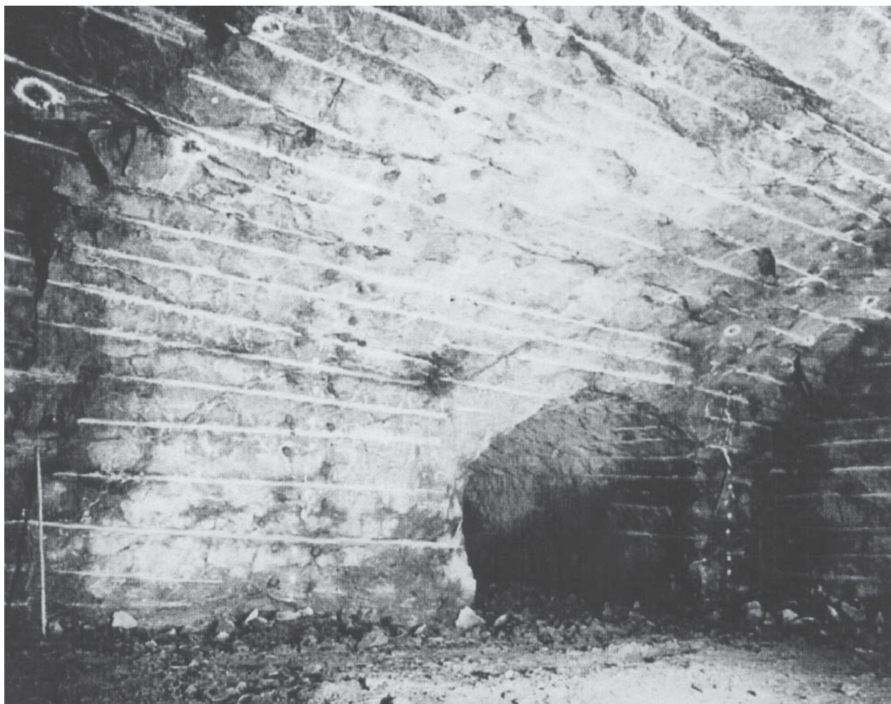
Рис. 3.46. Вид участка туннеля после проведения взрывных работ и отгрузки отбитой породы
