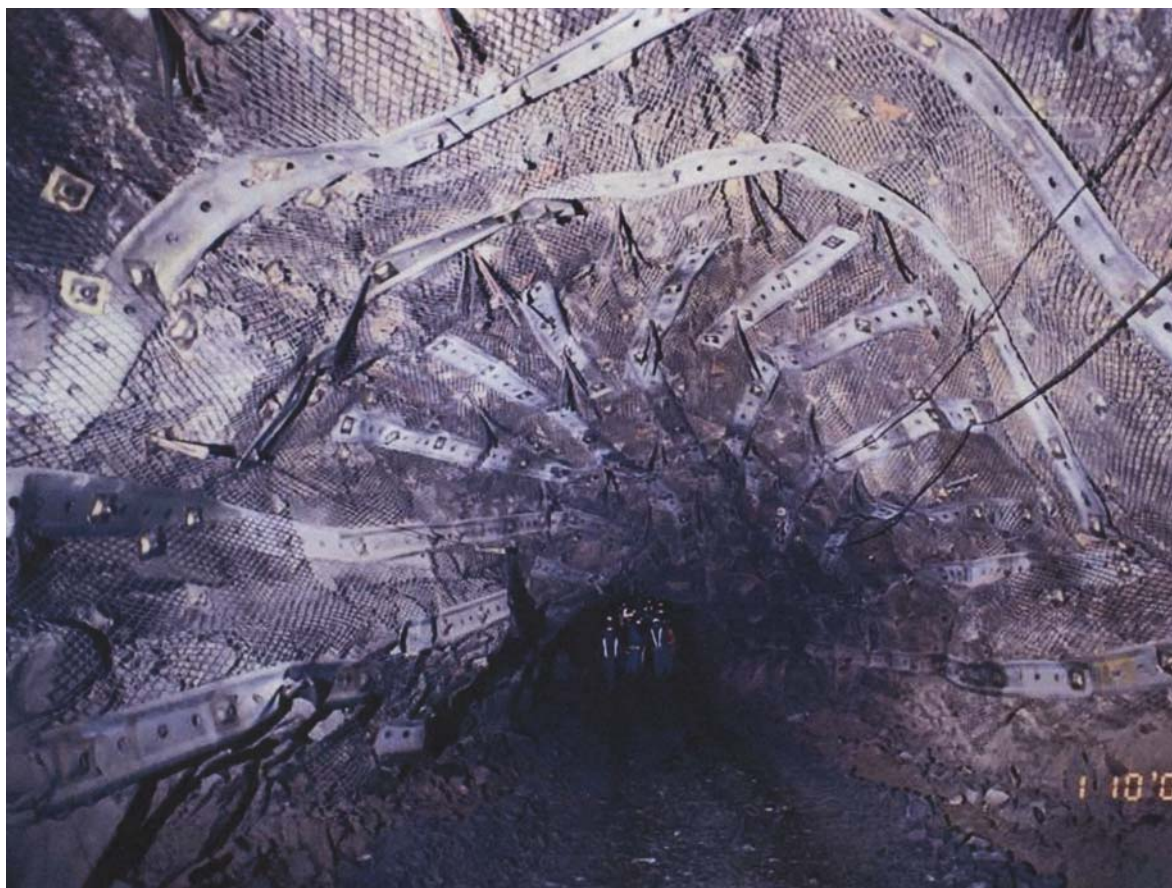
Рис. 4.28. Общий вид полости большого размера, закрепленной анкерной крепью с поддерживающей сеткой
