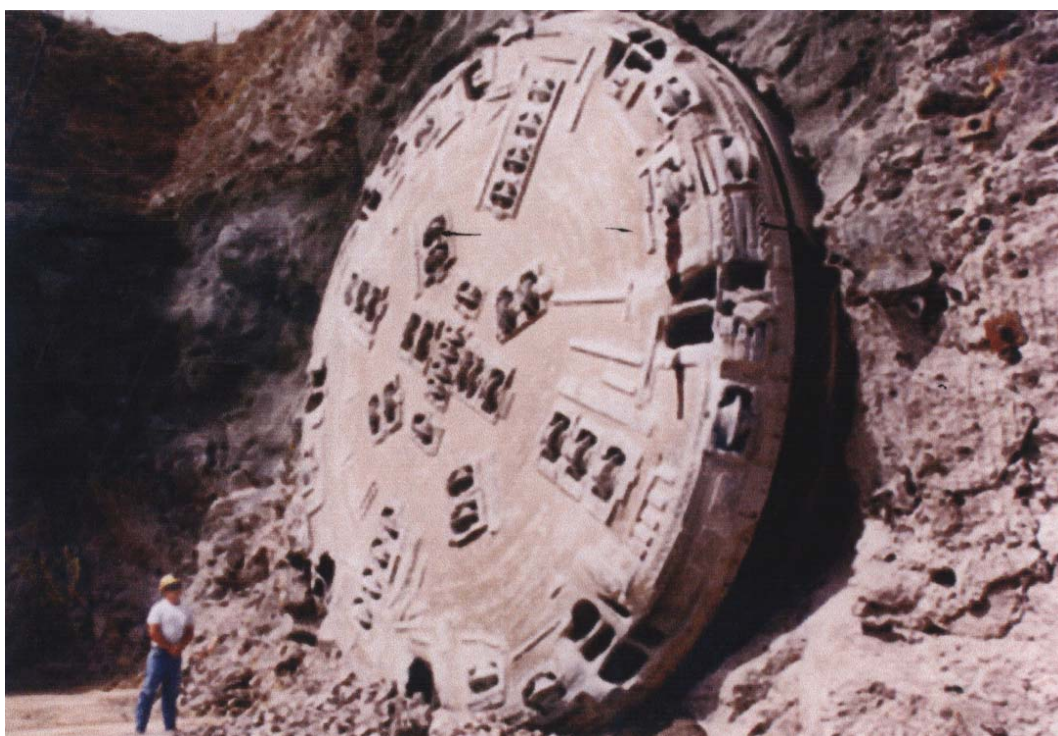
Рис. 1.25. Выход буровой проходческой машины на поверхность после окончания проходки туннеля ( комплекс хранилища ядерных отходов Юкка-Маунтейн)
