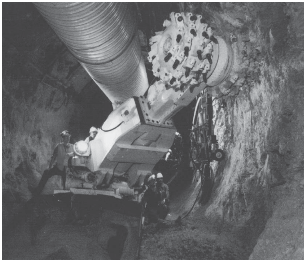
Рис. 3.12. Проходка ответвлений и ниш туннеля проходческим комбайном
