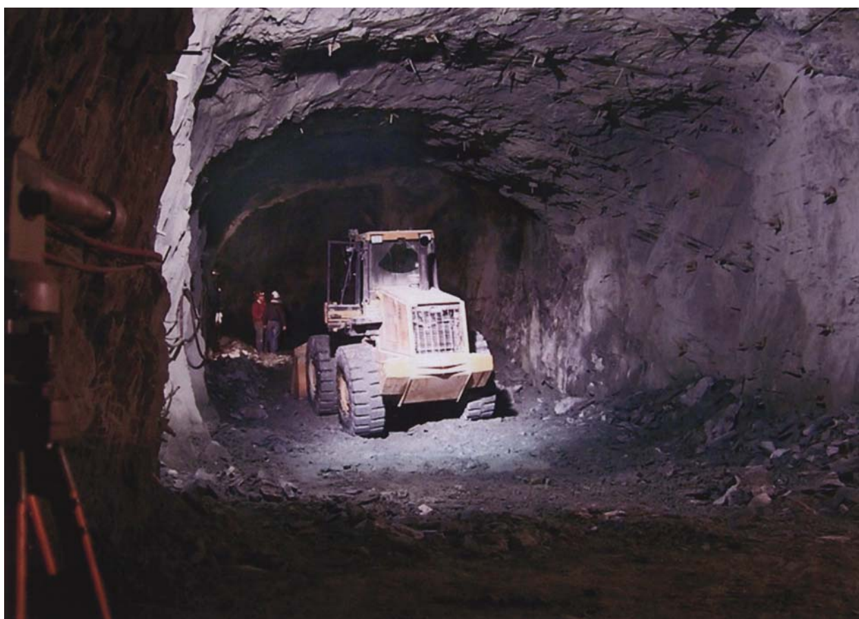
Рис. 4.12. Строительство полости «дальнего» детектора MINOS в шахте Саудан
