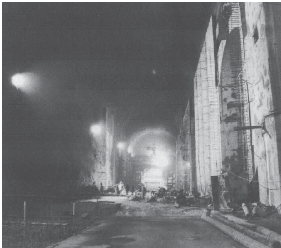
Рис. 2.50. Строительство главного машинного зала подземной электростанции Эртан
