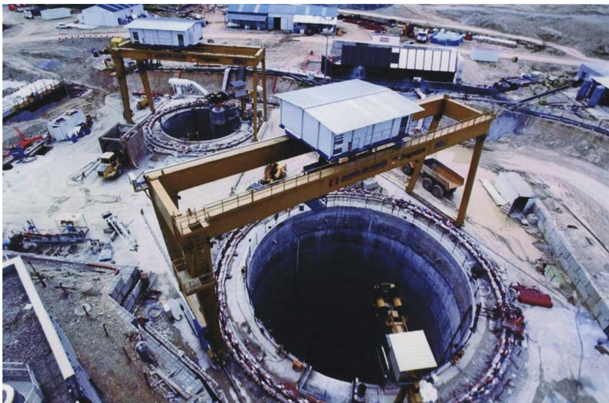
Рис. 4.100. Вид с поверхности на устье вертикальной шахты
