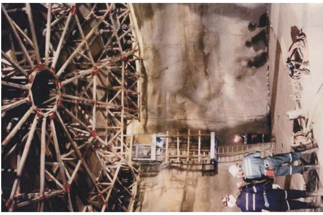
Рис. 4.75. Монтаж детектора SNO
