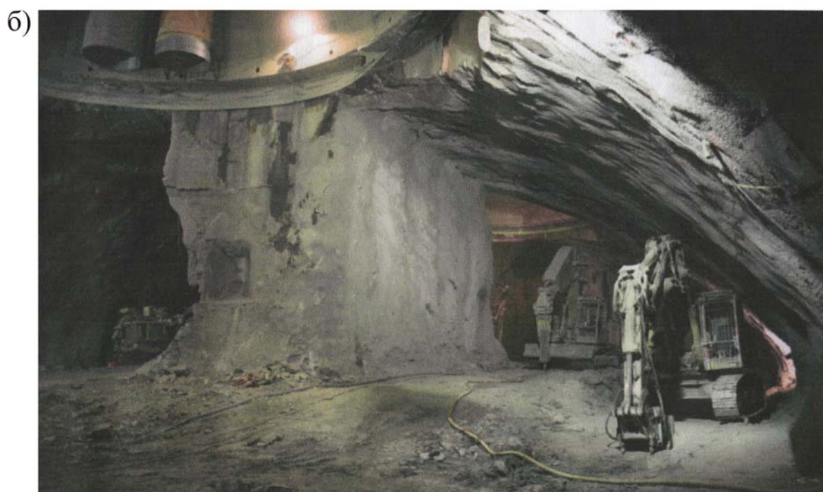
Рис. 4.104. Строительство полости UX15 детектора ATLAS
