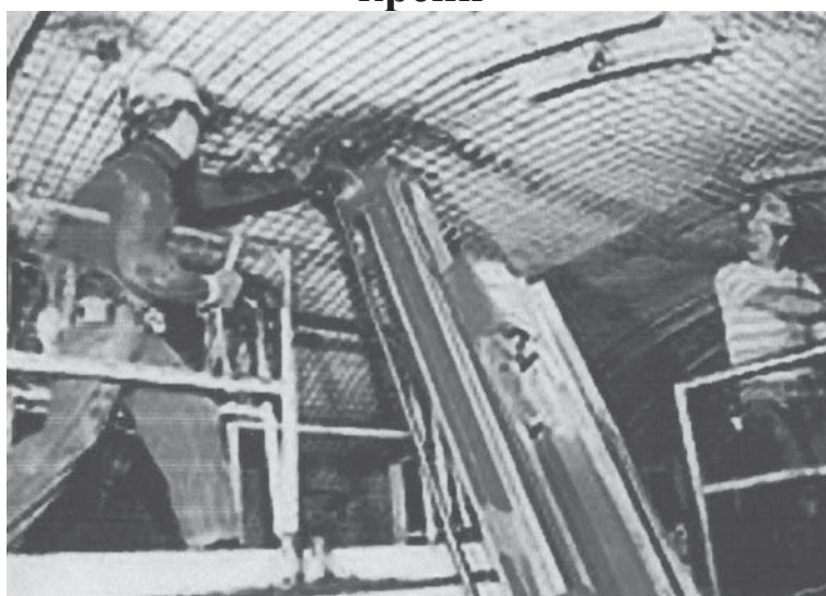
Рис. 3.14. Установка анкерных болтов и металлической сетки для крепления туннеля
