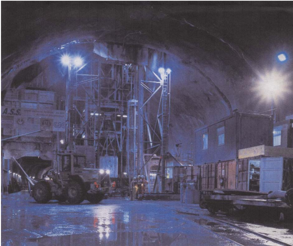
Рис. 1.18. Окончание формирования арочной кровли подземной выработки
