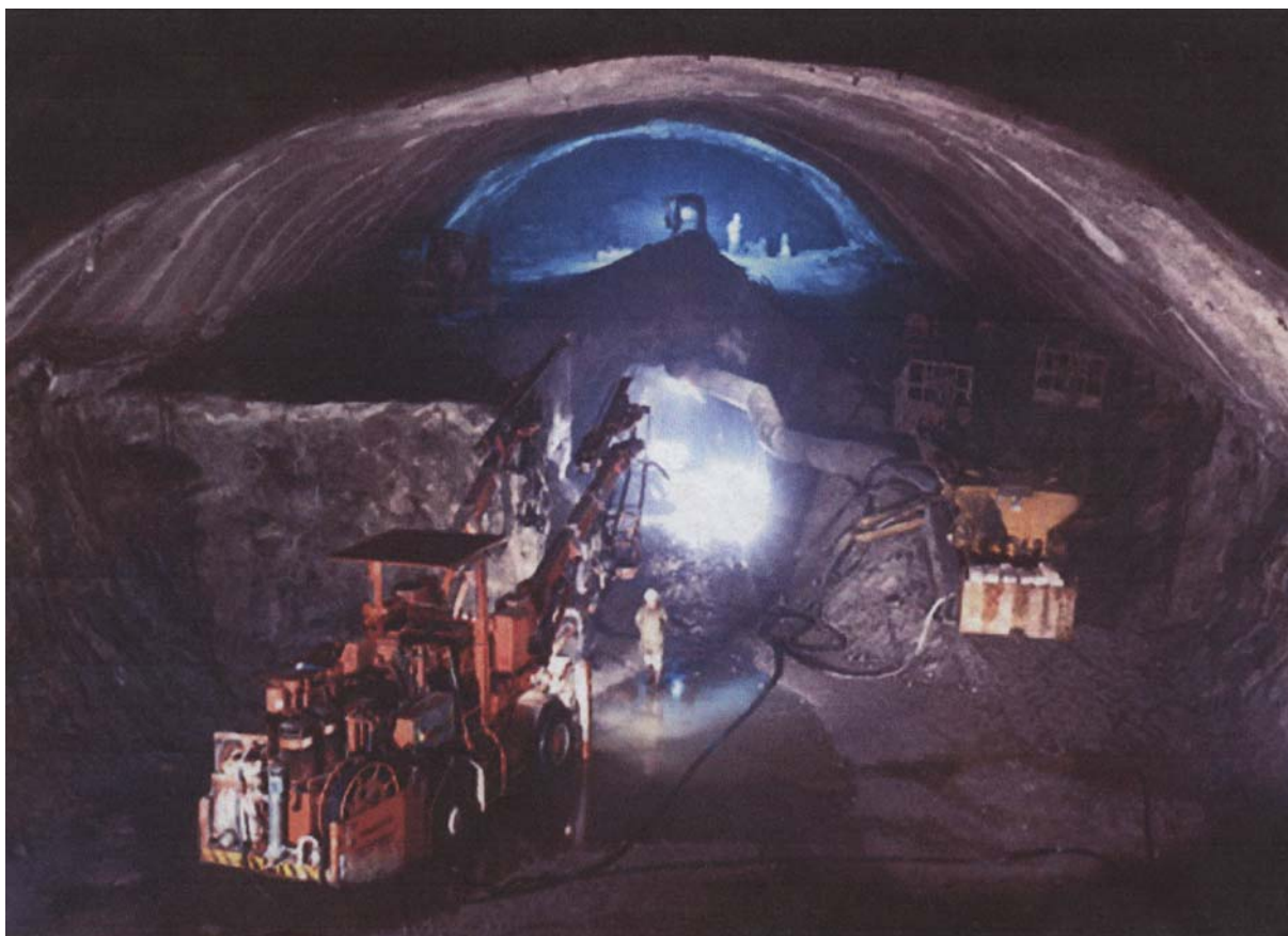
Рис. 4.88. Проходка полости буровзрывным способом (лаборатория Грэн Сэссо)
