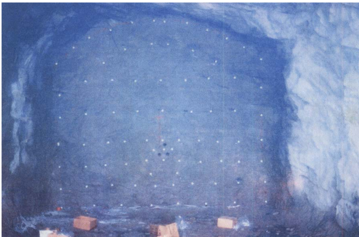
Рис. 1.15. Скважины в забое полости, подготовленные для последующего заряжания взрывным веществом
