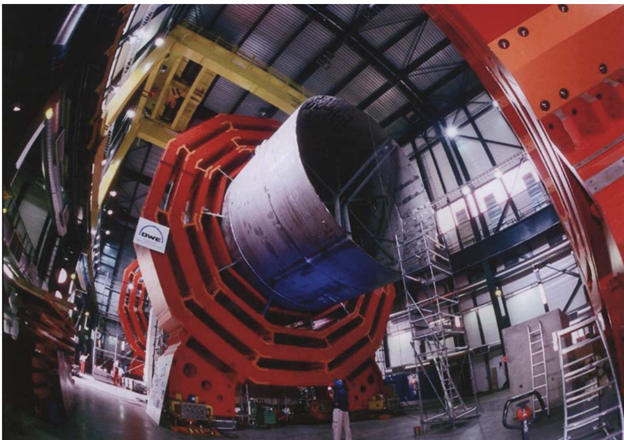
Рис. 4.98. Монтаж оборудования в полости ускорителя LEP/LHC
