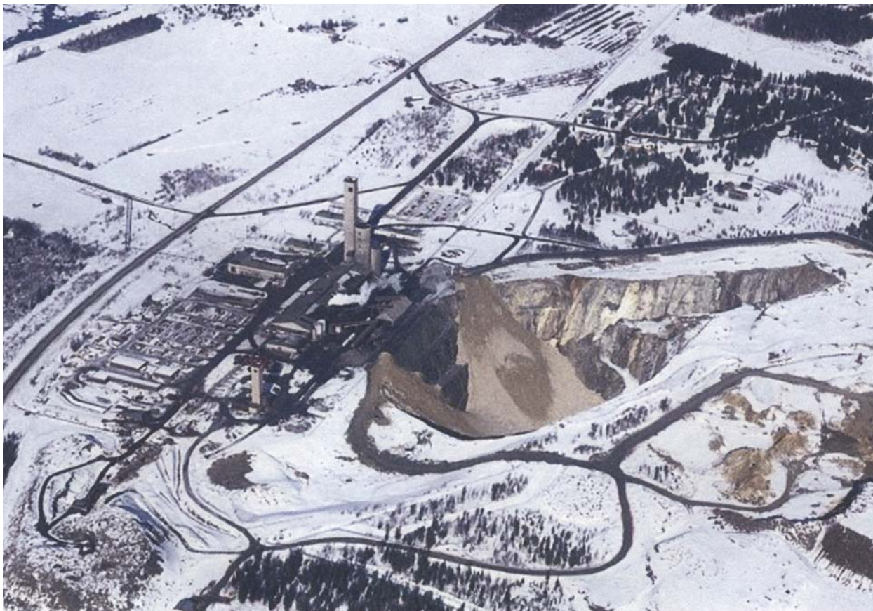
Рис. 4.47. Вид с воздуха на промплощадку шахты Пихасалми и прилегающий ландшафт
