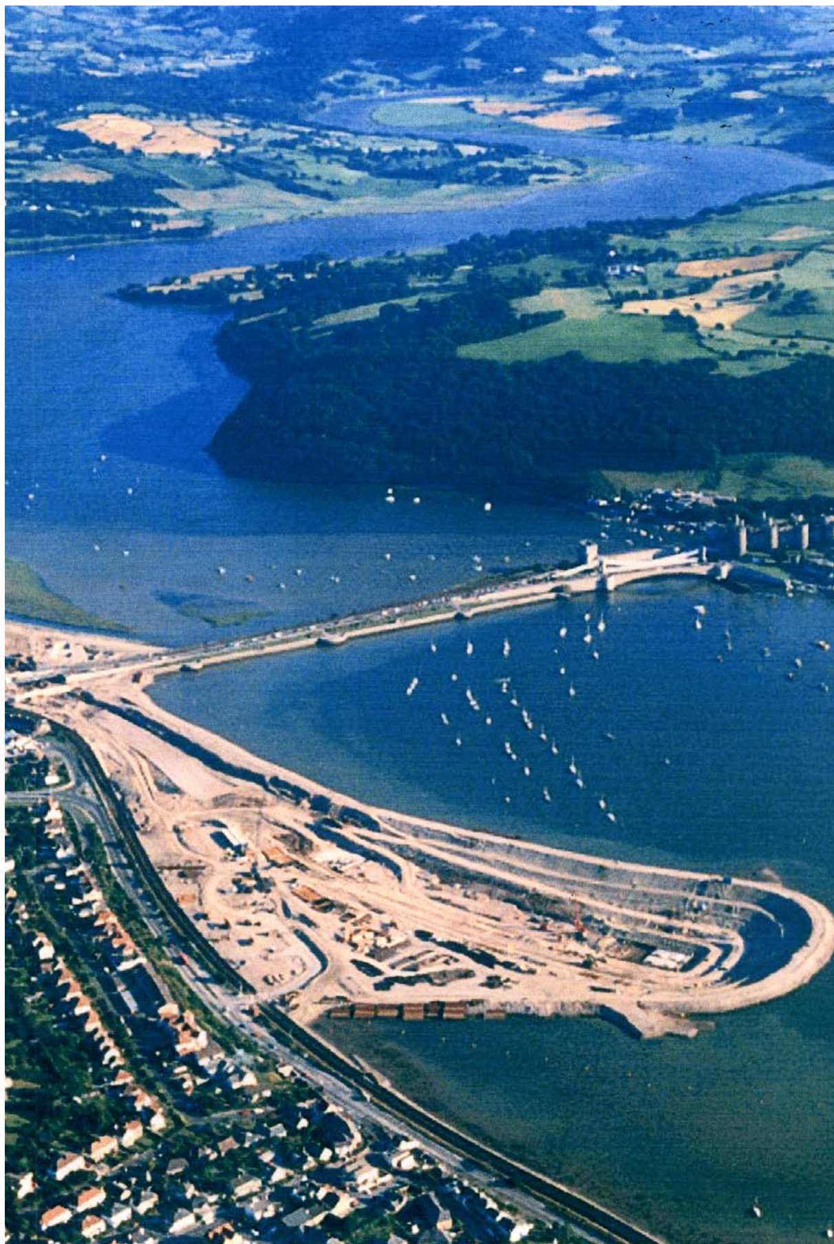
Рис. 5.22 Панорама строительства туннеля Конви
