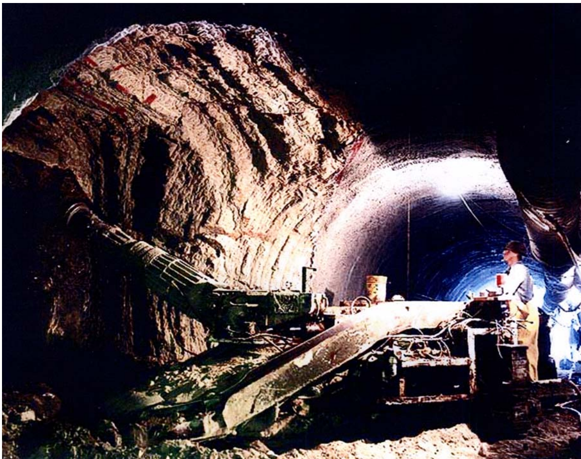
Рис. 2.136 Проходческие работы с использованием комбайна
