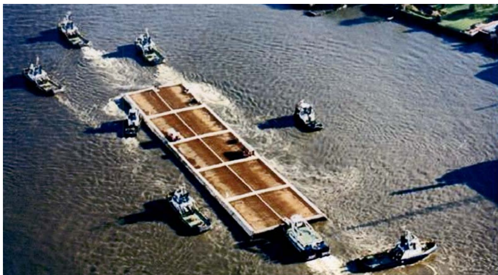
Рис. 5.7 Транспортировка туннельной секции к месту установки
