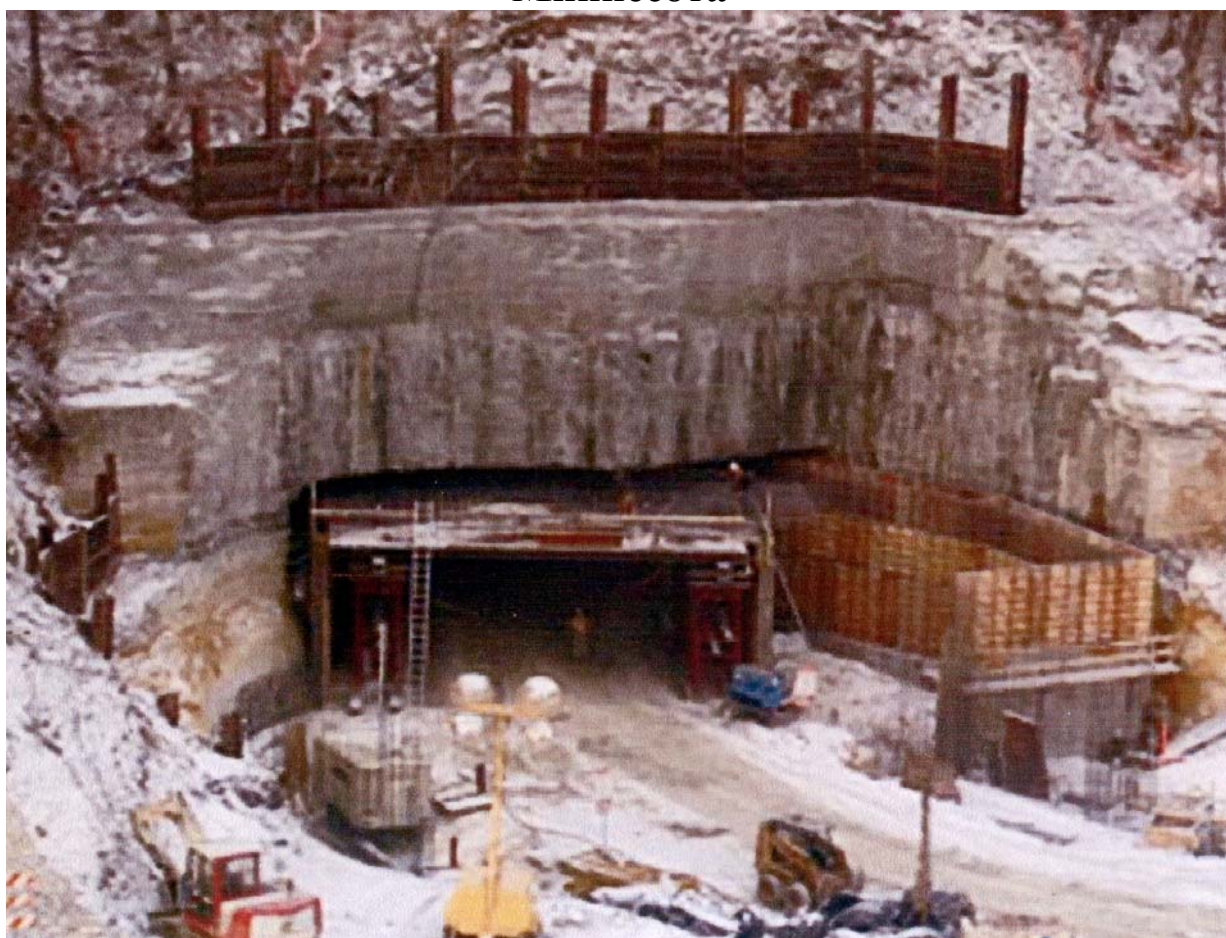
Рис. 2.19 Начальная стадия строительства
