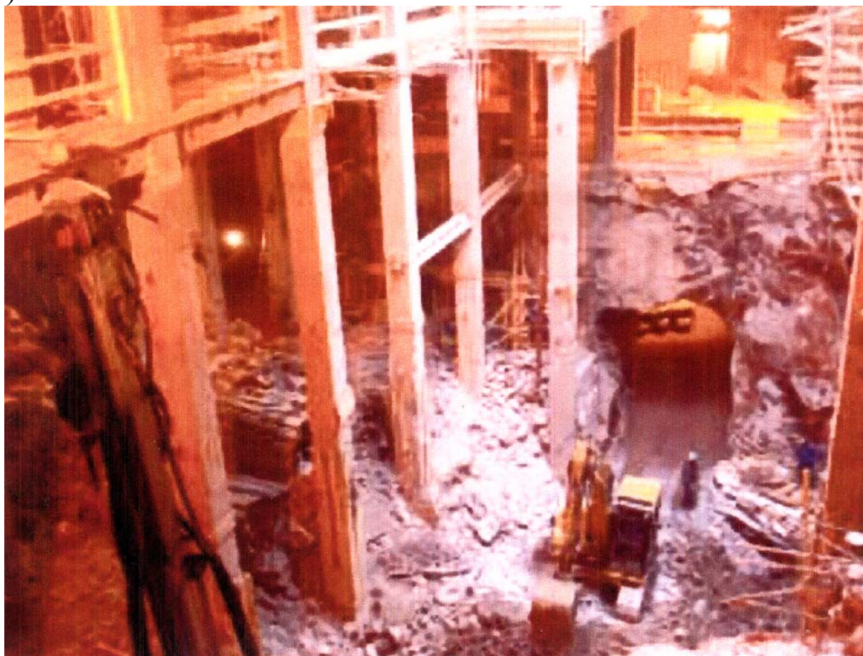
Рис. 2.76 План подземной части здания, погрузка отбитой породы (отель «Николаефф Хауз»)
