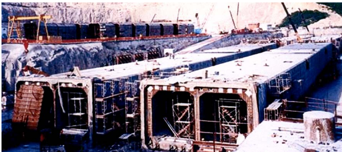
Рис. 5.4 Строительство железобетонных туннельных секций в бассейне (сухом доке)
