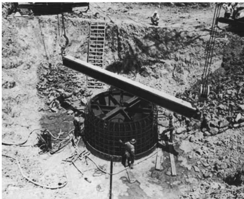
Рис. 3.13 Установка цилиндра постоянной крепи в пусковую шахту комплекса Минитмен
