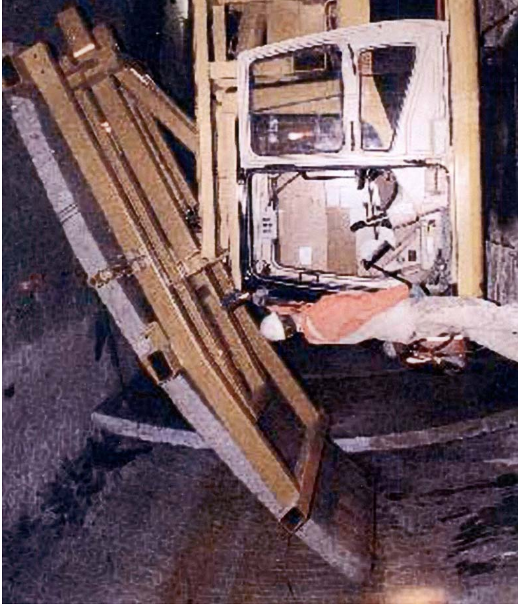
Рис. 2.20 Установка изогнутых железобетонных панелей крепи полости подземной части библиотеки университета Миннесоты
