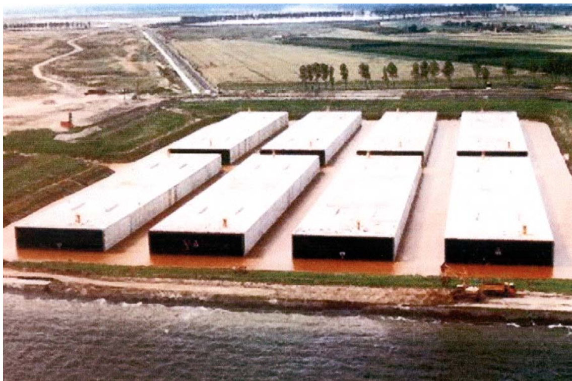
Рис. 5.34 Этапы строительства туннеля Лифкеншок
