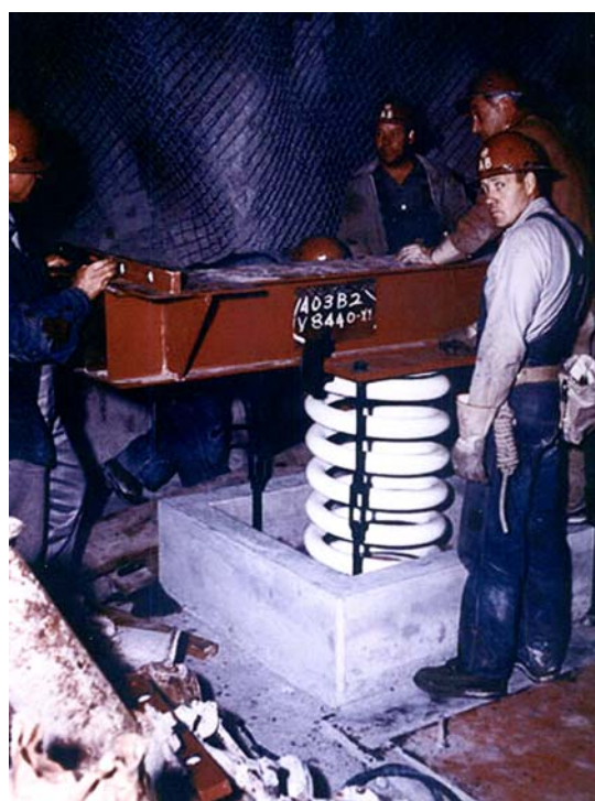
Рис. 3.23 Стабилизирующие пружины строений комплекса Сайт-Р Равен Рок
