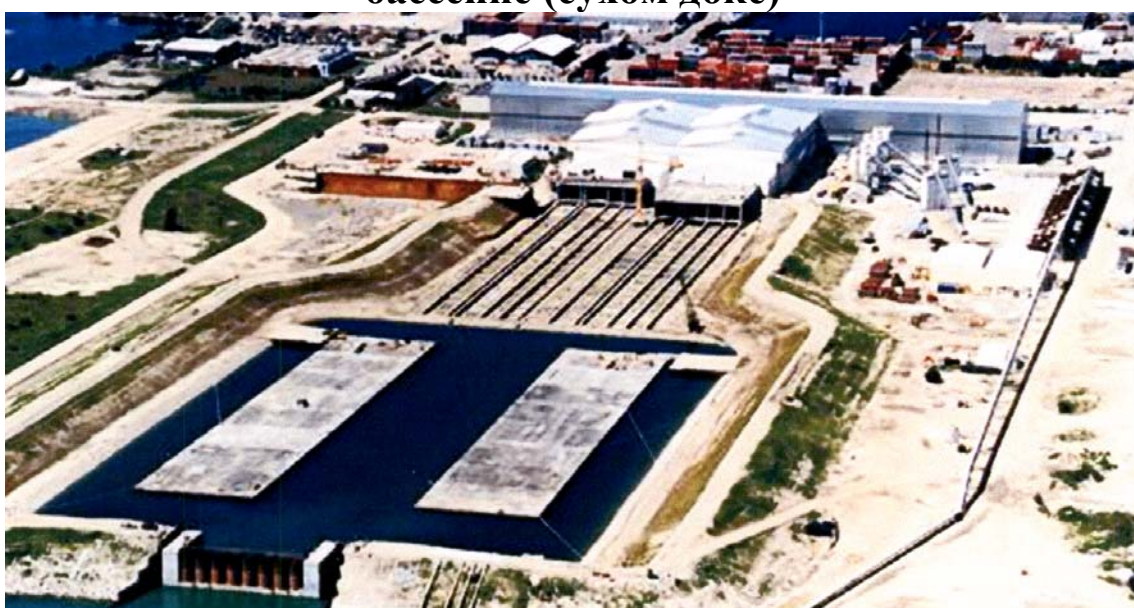
Рис. 5.5 Всплытие туннельных секций при заполнении бассейна
