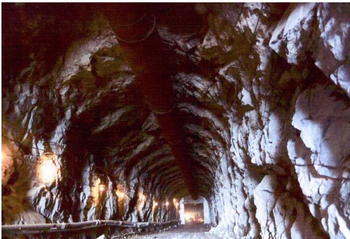
Рис. 2.138 Контур подземной полости при взрывных работах неудовлетворительного качества
