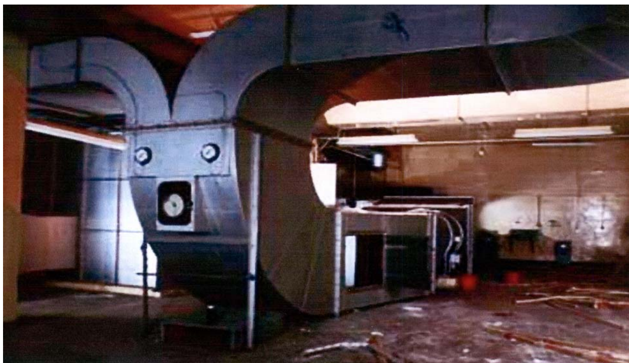
Рис. 3.26 Подземные телефонные станции центров военного управления, Великобритания
