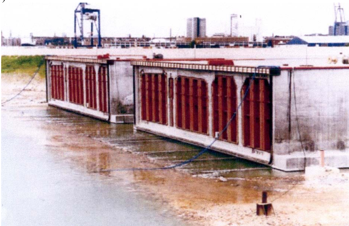
Рис. 5.28 Изготовление и транспортировка туннельных секций
