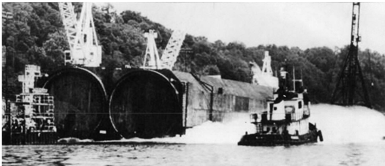
Рис. 5.13 Секции туннеля Макгенри перед транспортировкой к месту установки
