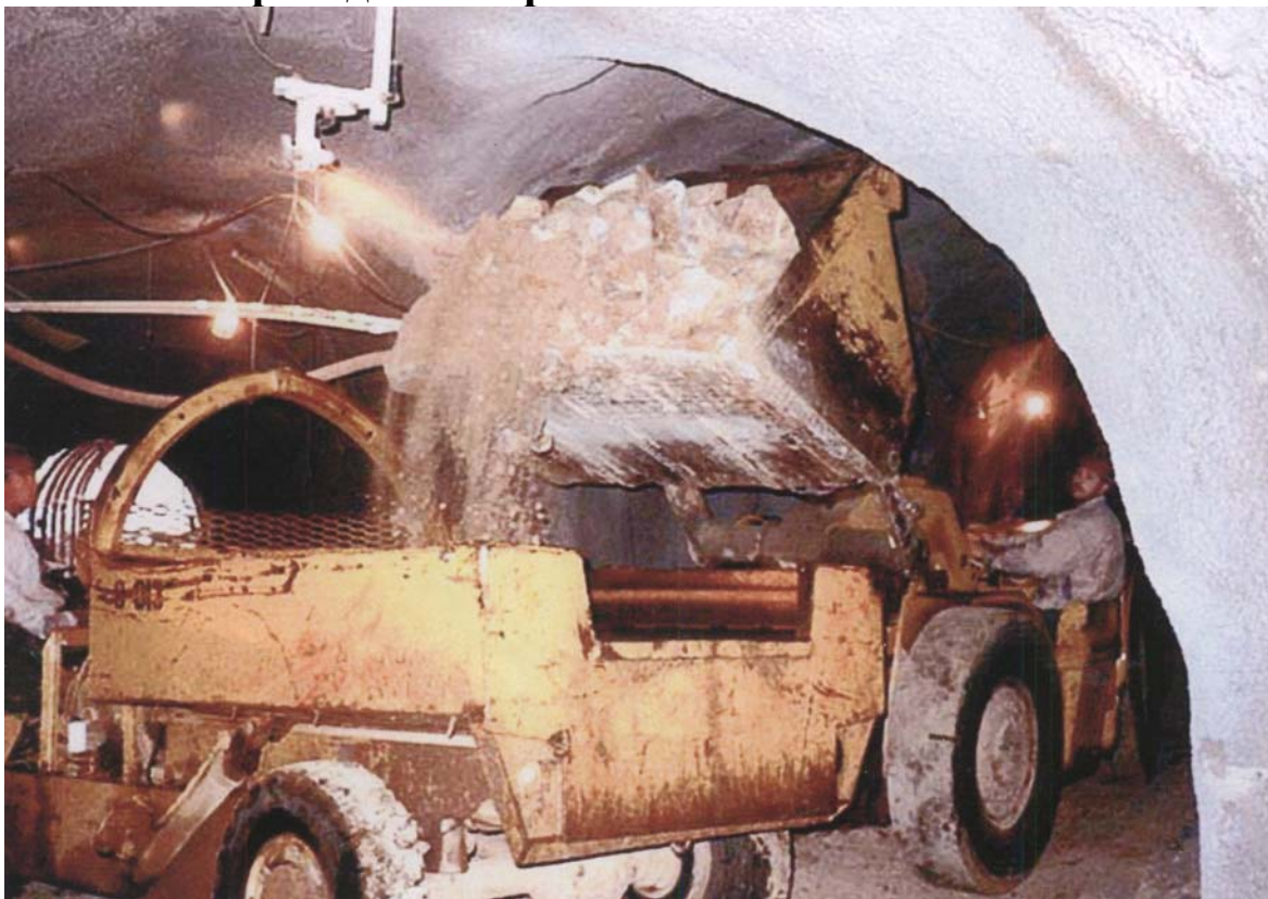
Рис. 2.137 Погрузка породы после проведения взрывных работ при сооружении винного погреба
