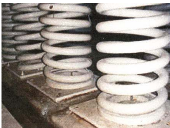
Рис. 3.23 Стабилизирующие пружины строений комплекса Сайт-Р Равен Рок
