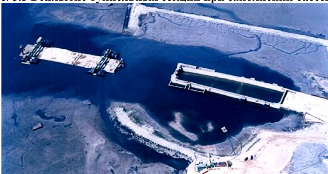
Рис. 5.6 Выход туннельной секции за пределы бассейна
