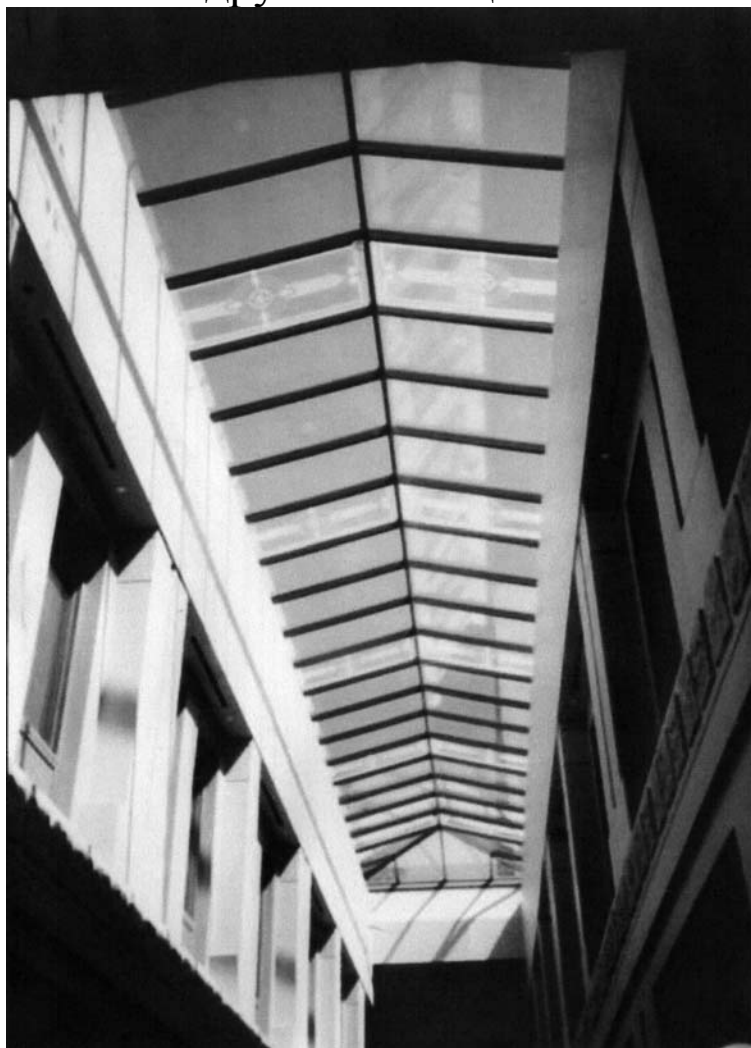
Рис. 2.7 Застекленная крыша подземного коридора парламента Техаса
