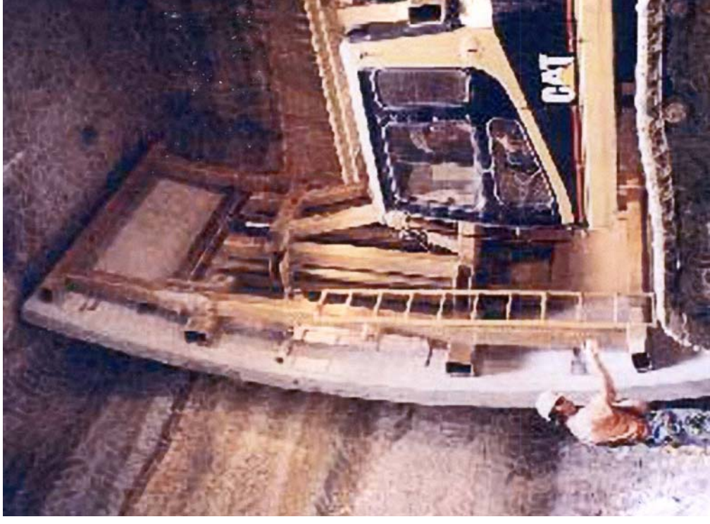
Рис. 2.20 Установка изогнутых железобетонных панелей крепи полости подземной части библиотеки университета Миннесоты
