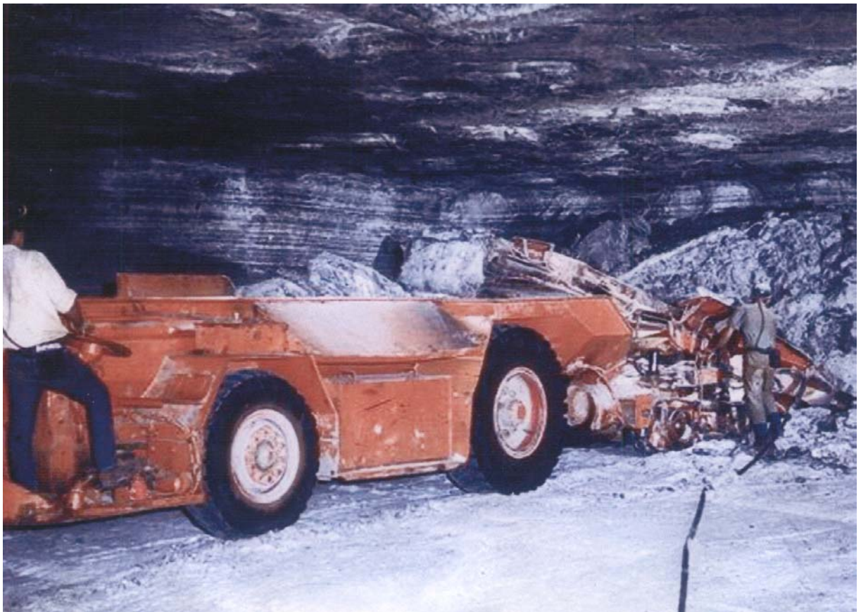
Рис. 2.156 Погрузка породы после проведения взрывных работ
