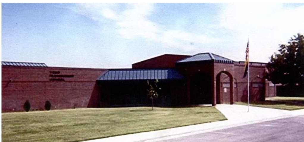
Рис. 3.29 Наземные здания школы Або
