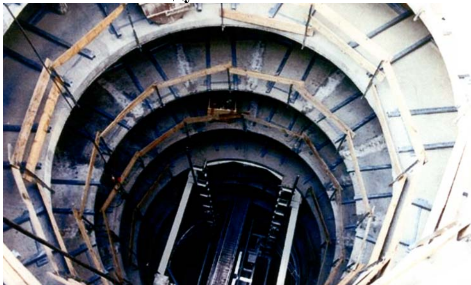
Рис. 2.102 Размещение лифтовой системы в парковочном цилиндре
