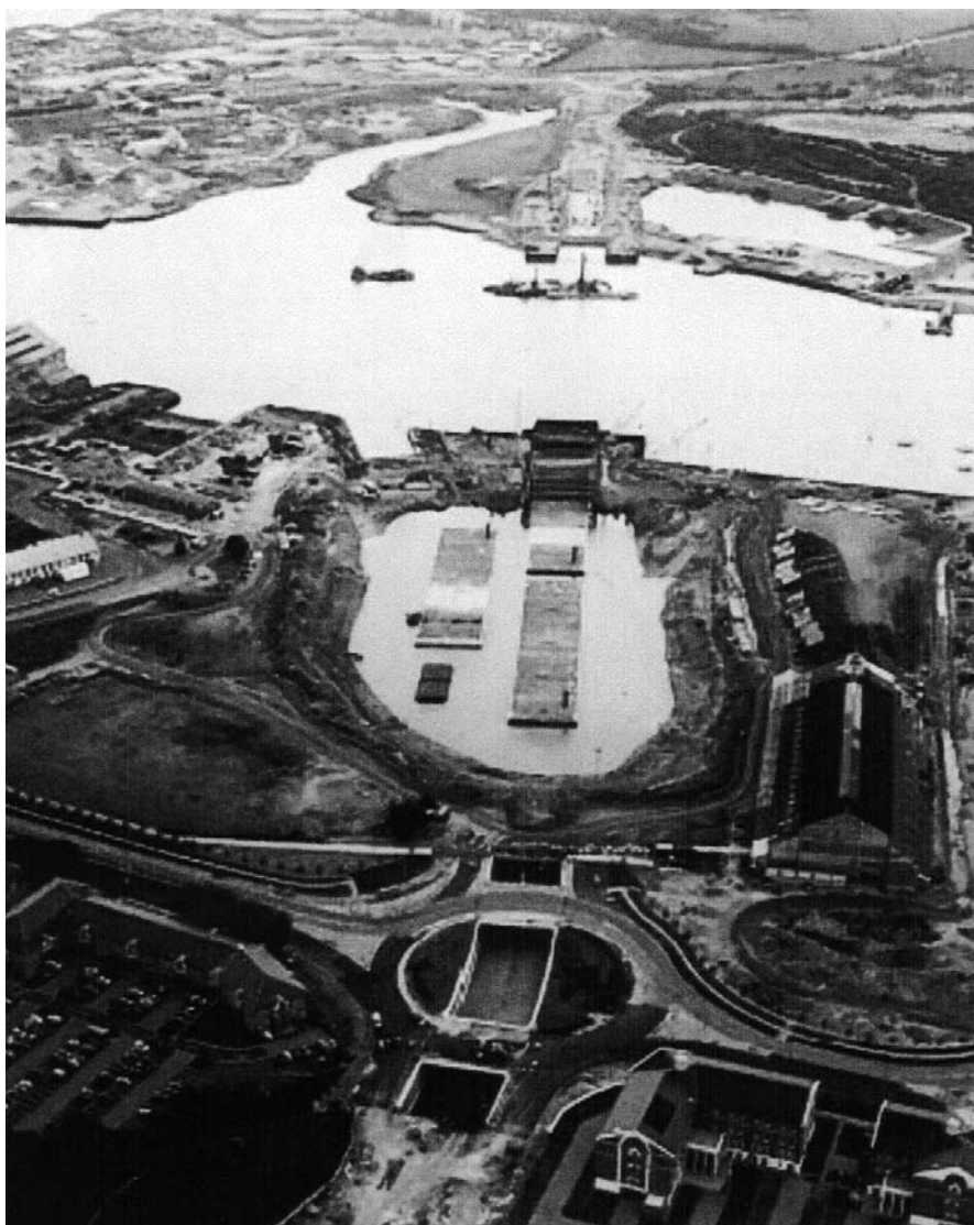
Рис. 5.18 Туннельная секция в частично заполненном бассейне
