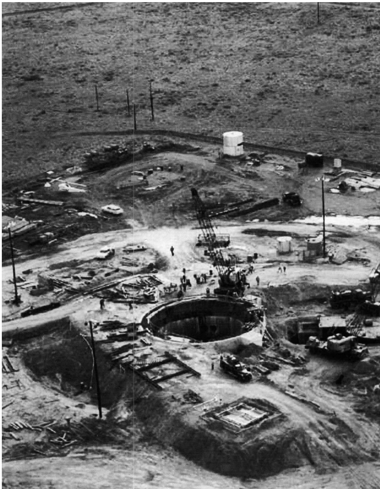
3.12 Сооружение пусковой шахты Атлас
