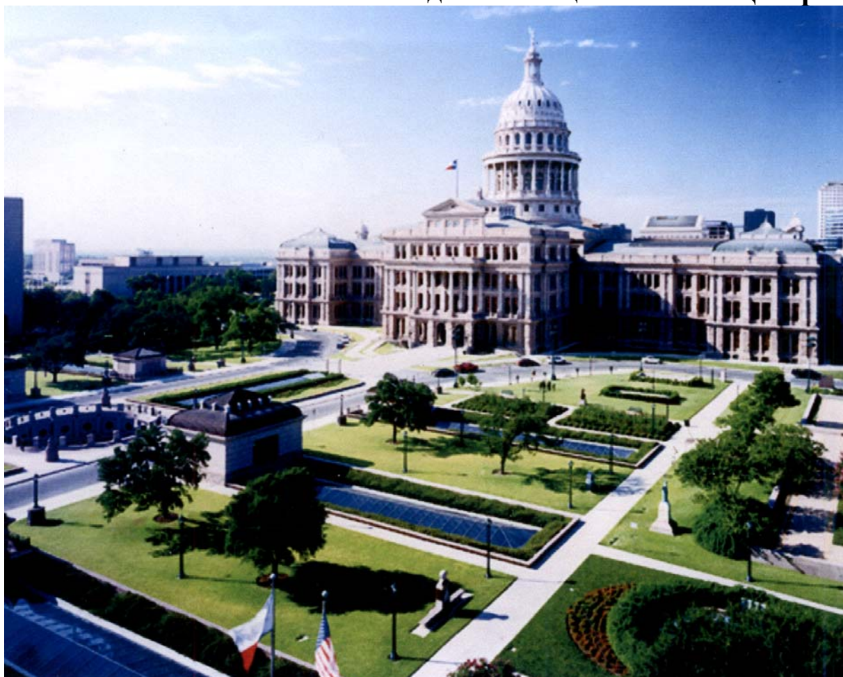
Рис. 2.5 Общий вид парламента штата Техас (видны застекленные крыши подземных коридоров)
