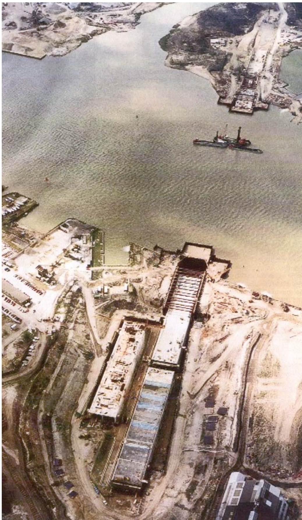
Рис. 5.19 Сталкивание с берега реки готовой секции в траншею туннеля Конви
