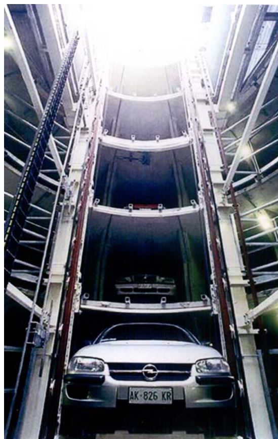
Рис. 2.99 Подъемник лифтовой парковочной системы
