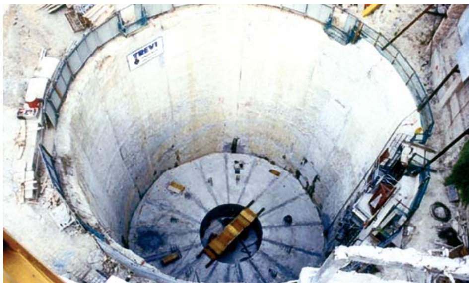
Рис. 2.100 Железобетонный силос парковочной системы
