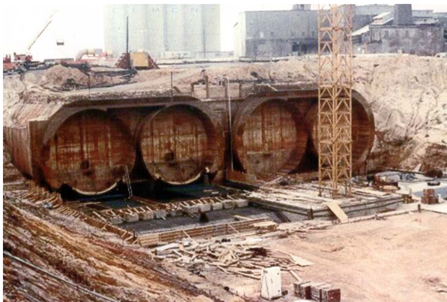
Рис. 5.11 Секции туннеля Макгенри в сухом доке
