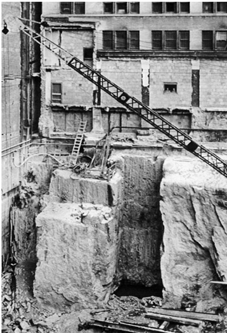
Рис. 2.35 Котлован для подземной части библиотеки Моргана
