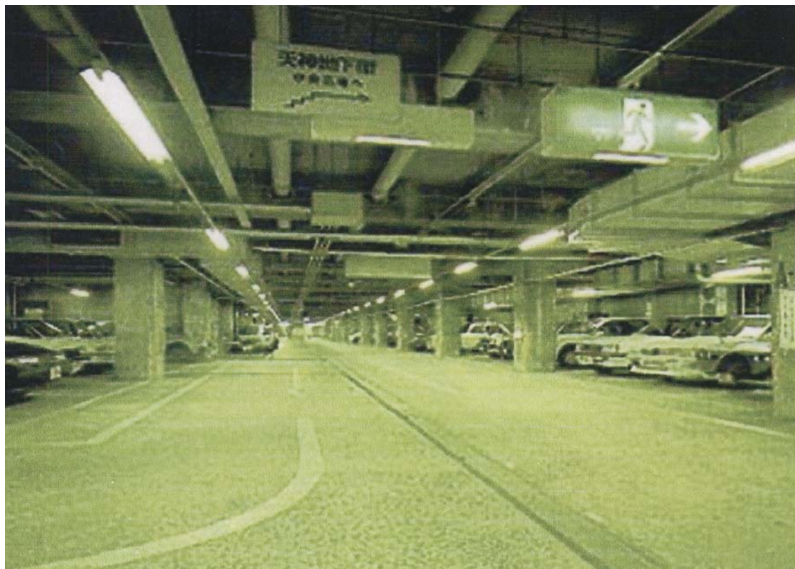
Рис. 2.93 Подземная автостоянка в Фукуока, Япония
