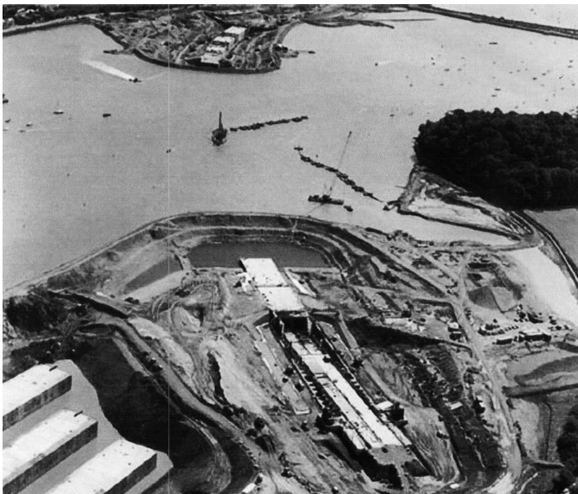
Рис. 5.21 Строительство портала и заезда туннеля Конви
